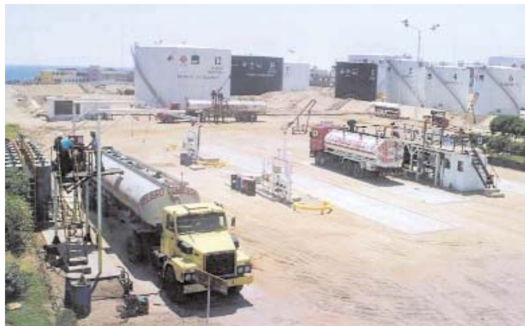
Zona de despacho y tanques. / Dispatch and tanks area.
