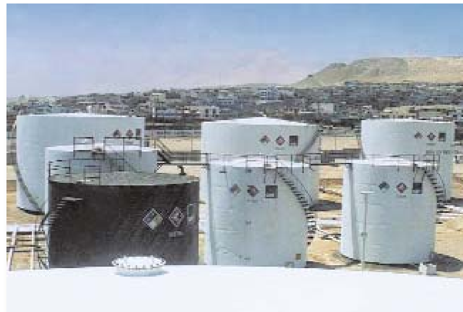
Zona de tanques. / Tanks area.
