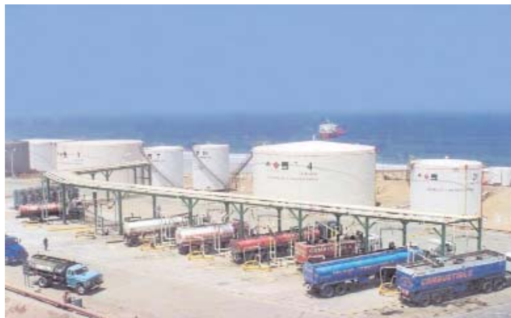
Zona del Nuevo Sistema de Despacho Dual, nuevo tanque número 21 de gas - 90, zona baja del patio de tanques y el amarradero multiboya. New Dual Dispatch System area (Top and Bottom Loading), new gas tank N° 21-90, tanks low area and buoyage mooring.
