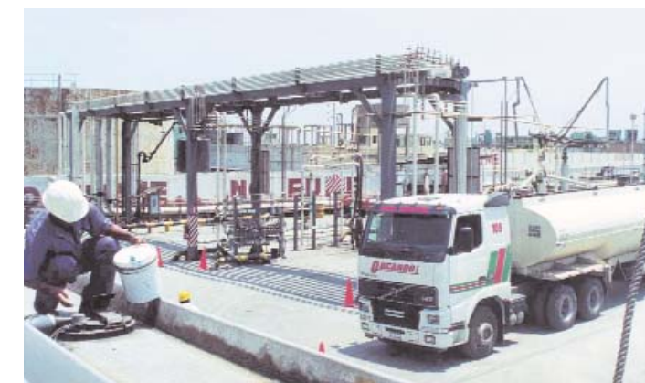
Zona de despacho y aditivación. / Dispatch and additivation area.
