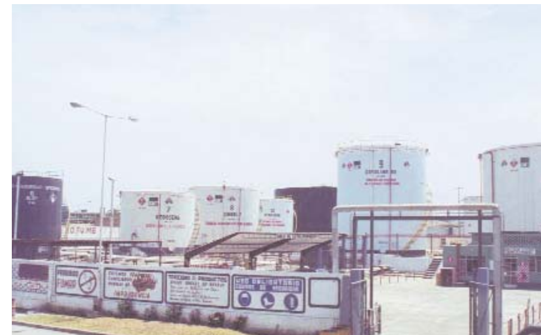
Zona de tanques. / Tanks area
