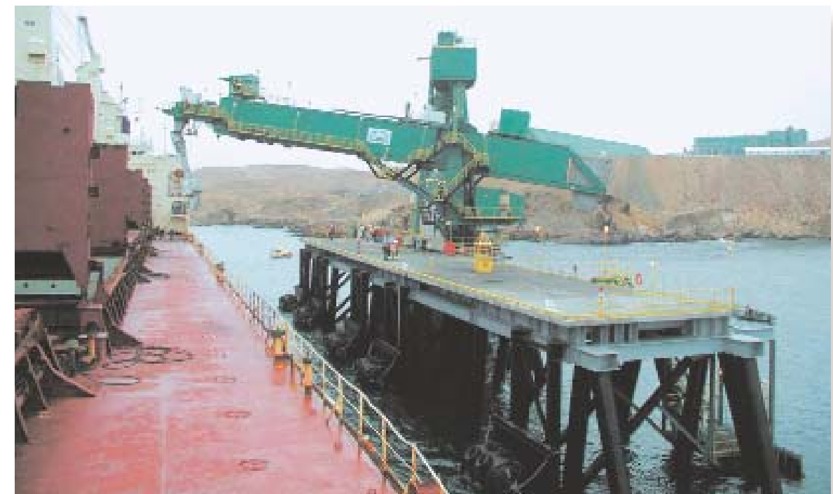
Inicio de operaciones de embarque en el muelle de Antamina. / Beginning load operations at the Antamina pier.
