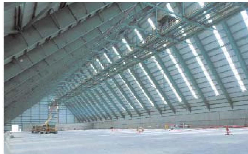
Almacén de Minerales. / Minerals warehouse.
