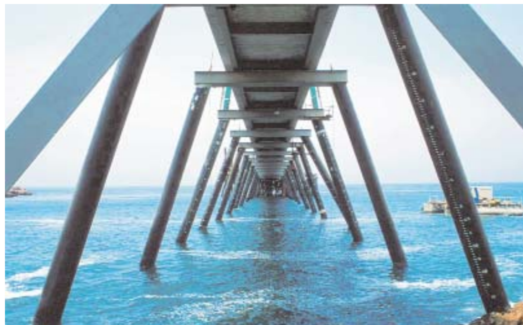
Estructura del muelle Punta Lobitos. / Punta Lobitos pier structure.
