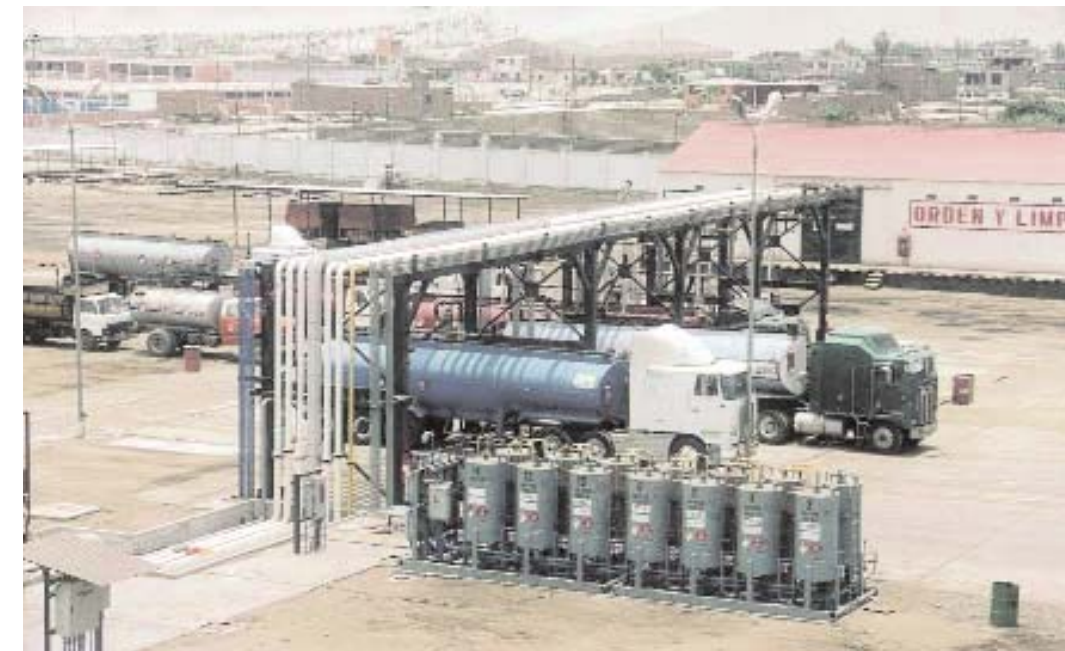
Zona del Nuevo Sistema de Despacho Dual. / New Dual Dispatch System area (Top and Bottom Loading).
