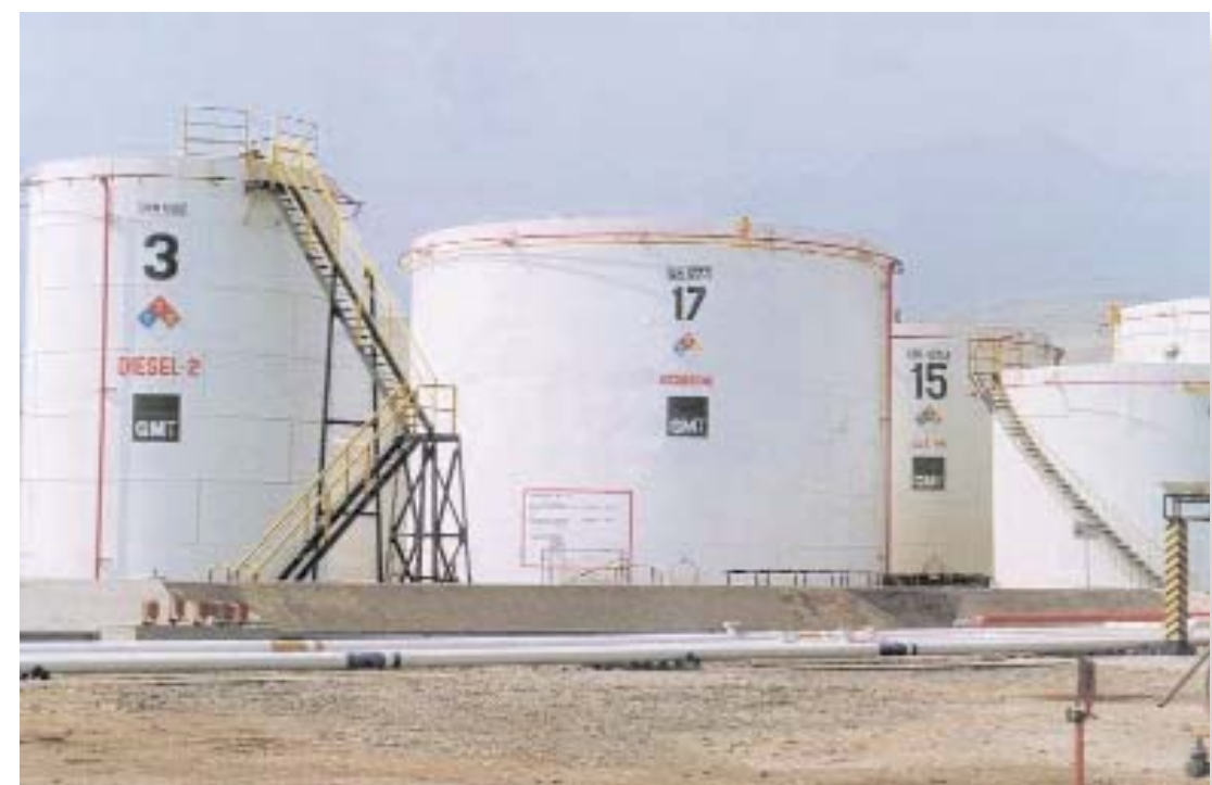
Zona de tanques. / Tanks area.
