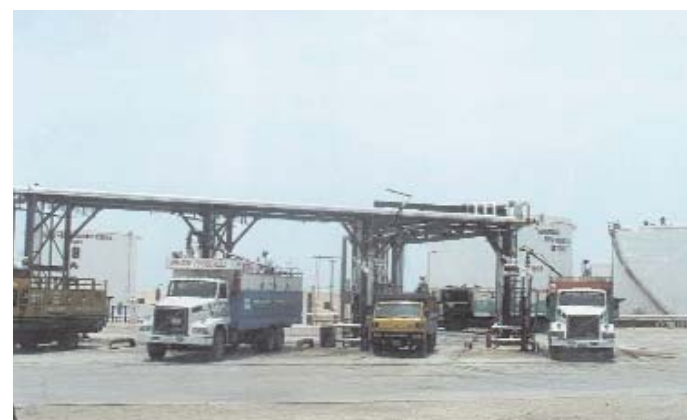
Zona de despacho / Dispatching area.
