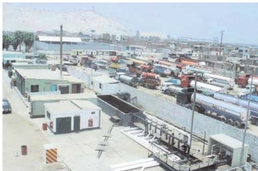
Zona de estacionamiento en el Terminal Eten. / Eten Terminal Parking area.
